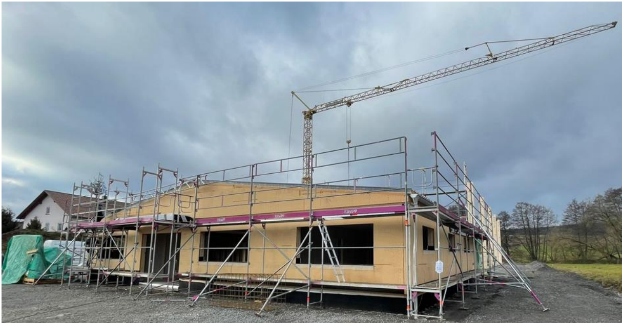
Das neue Gebäude von Rainbow International (Foto: Löber)
